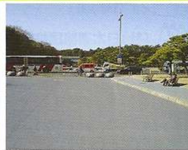
皇居桜田門前の施工写真
