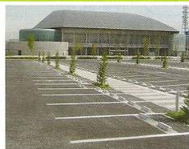
スカイホール豊田の施工事例
